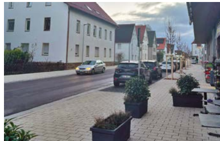
Kaum Radverkehrsförderung in Münchingens neugestalteter Stuttgarter Straße
